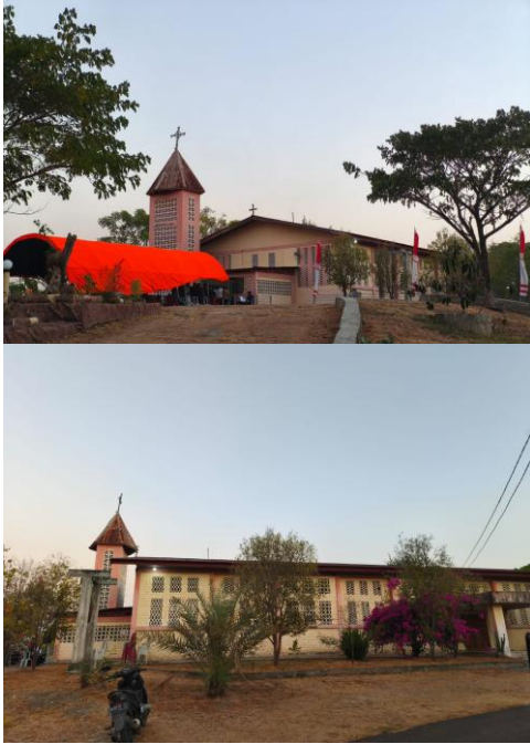
Kondisi Bangunan pada Batuan
