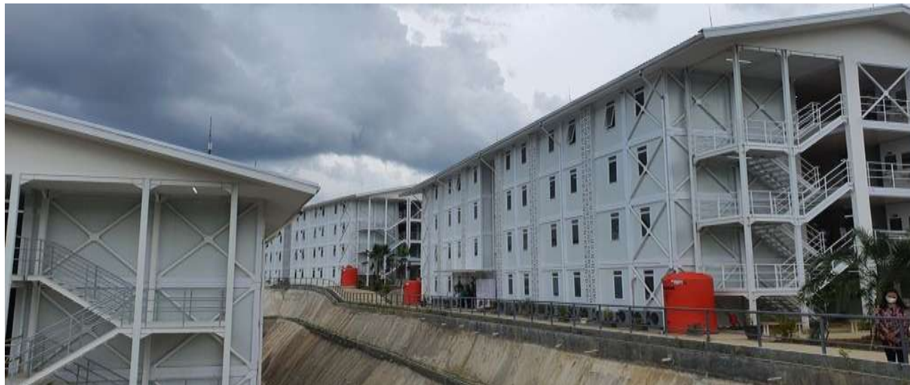
Rumah susun pekerja konstruksi di Ibu Kota Nusantara terus dibangun. Saat ini sudah 7.800 pekerja konstruksi berada di IKN mengerjakan persiapan lahan maupun menyelesaikan penyediaan rusun. Foto diambil Kamis (23/2/2022)
